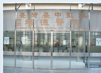
■臺灣臺中監獄附設培德醫院
