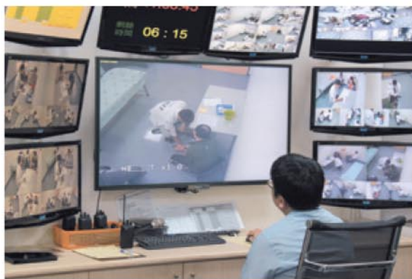
在中央控制室，可看到各間考場的狀況。
